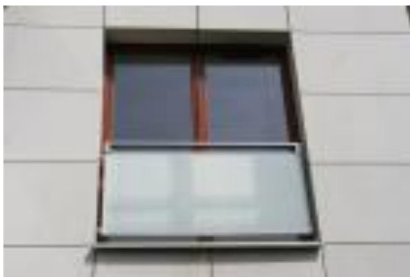
13. Przykład balustrady zewnętrznej
